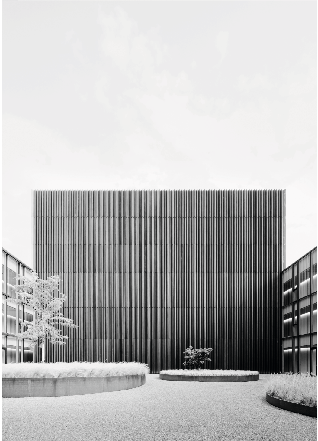
Abb. 6: Innenhof mit Archiv
