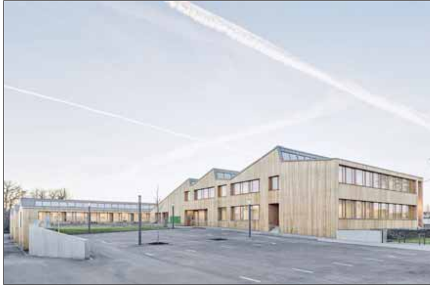
Im oberen Gebäudeteil der Sozialwerkstätten sind medizinische Praxen untergebracht, die auch Menschen aus der Umgebung zur Verfügung stehen.
