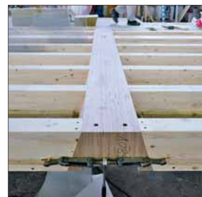
Die Deckenelemente verfügen über einen mittleren Querträger aus Buchen-Furnierschichtholz, der als Auflager für die Elemente des Obergeschosses dient. Fotos: Merz Kley Partner (2)
