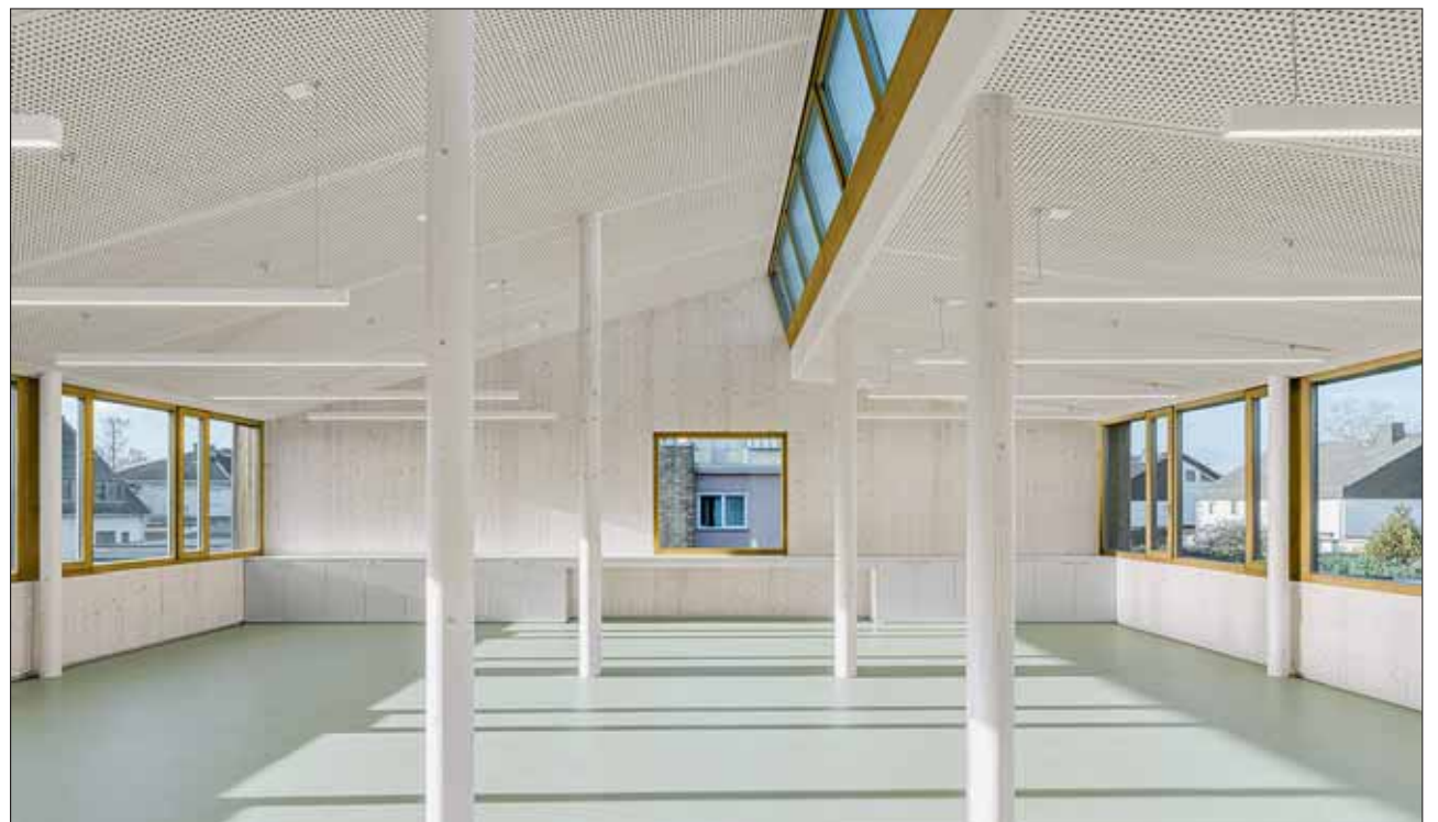
Die Werkräume warten mit runden, an den Kreuzungspunkten der Deckenelemente punktgestützt platzierten BSH-Stützen auf. Fotos: Thilo Ross, Heidelberg (3)
