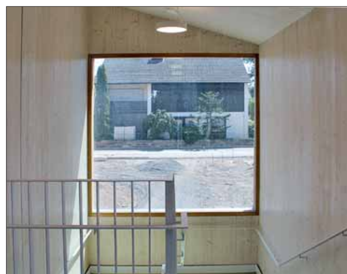
Die Einhausung der Treppenhäuser erfolgte mit vorgefertigten, sichtbar belassenen Brettsperrholz-Elementen.
