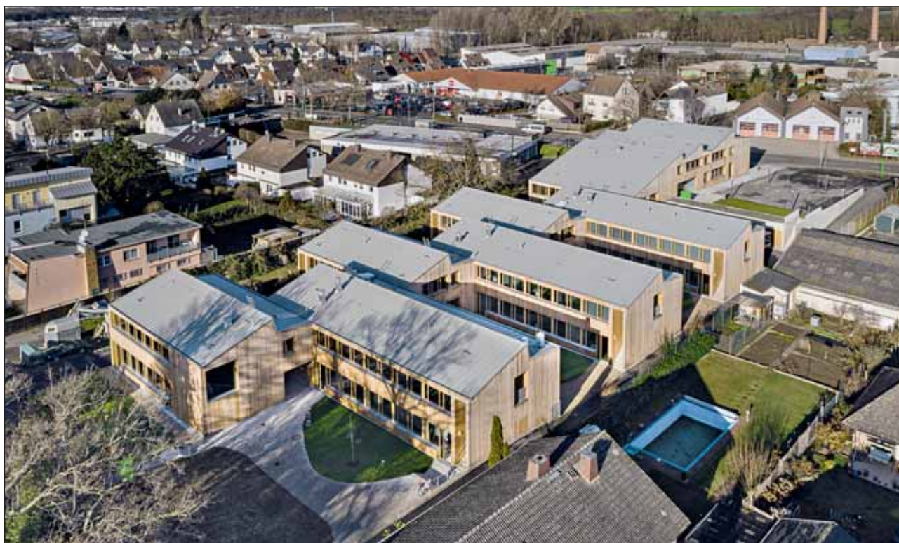
Die neuen Sozialwerkstätten in Neuwied fügen sich mit ihrer aufgelockerten, kammartigen Struktur in das bestehende Siedlungsgefüge ein. Foto: Thilo Ross, Heidelberg
