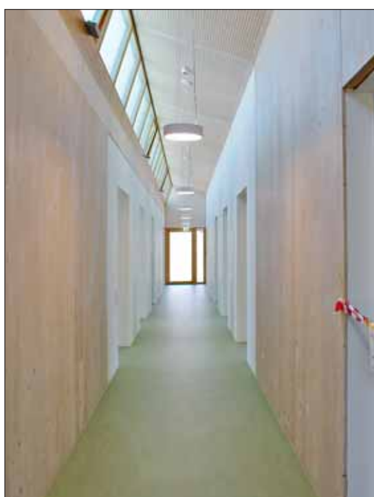
Die freundlich anmutenden Flurzonen verfügen über sichtoffene Massivholzwände und einen natürlichen Tageslichteinfall mittels Sheddach.
