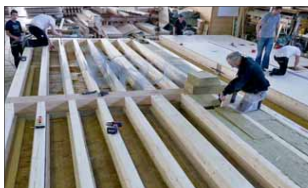
Die zwischen den Rippen brandschutzbedingt mit Mineralwolle gedämmten Deckenelemente wurden von Holzbau Amann bereits werkseitig mit den raumfertigen Akustikplatten bekleidet.
