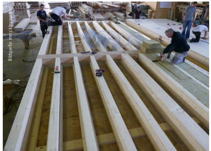
Die Zwischenräume der Hohlkasten-Deckenelements dämmt man wie gehabt brandschutzbedingt mit Mineralwolle aus.
