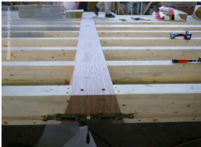
Ein in das Hohlkasten-Deckenelement integrierter, mittig angeordneter Querträger aus Buchen-Furnierschichtholz der Festigkeitsklasse GL75 lagert im Erdgeschoss auf BSH-Stützen und dient zugleich als Auflagerfläche für die Elemente des Obergeschosses.
