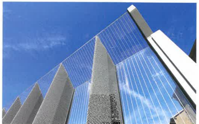
Bild 2. Die transparente Einlage des Lärmschutzsystems besteht aus 12 bis 20 mm Acryl, Silikatglas oder Polycarbonat – geschützt unter dem Lochblech, befindet sich das Absorptionsmaterial aus Mineralfaser (Fotos: R. Kohlhauer GmbH)
